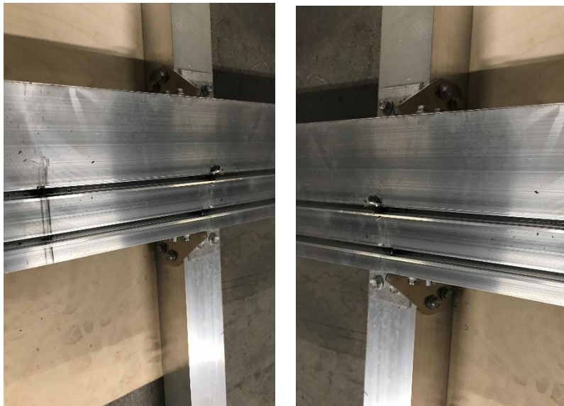
Abbildung 15 und 16 Fotodokumentation Details der Montagestelle
