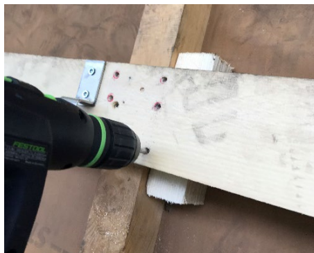
Illustration 10 Pré-percer les trous de montage
