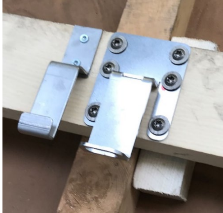
Illustration 12 Vis de montage serrées
