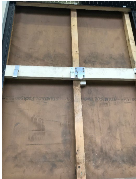
Illustration 13 Photo de vue d'ensemble du dispositif d'ancrage monté
