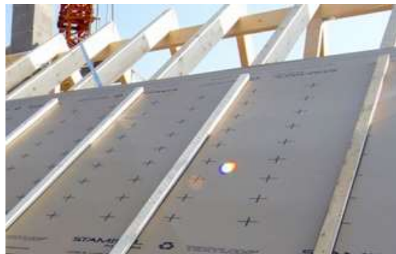
Abbildung 2: Regensicheres Unterdach (nach ZVDH)
