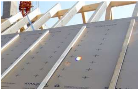
Abbildung 1: Regensicheres Unterdach (nach ZVDH)
